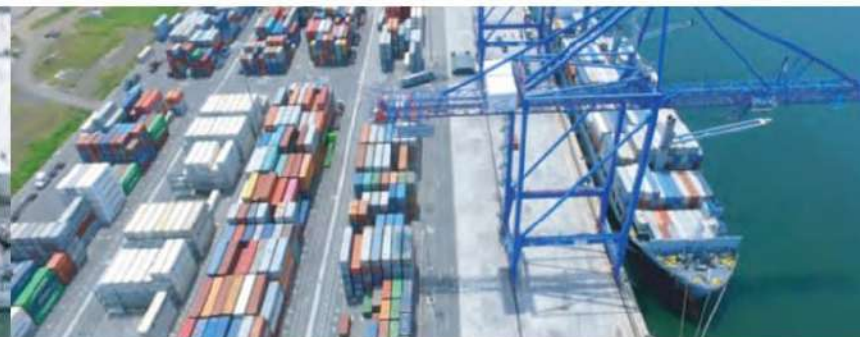
Depósito Aduanero Temporal APM Terminals Quetzal.
