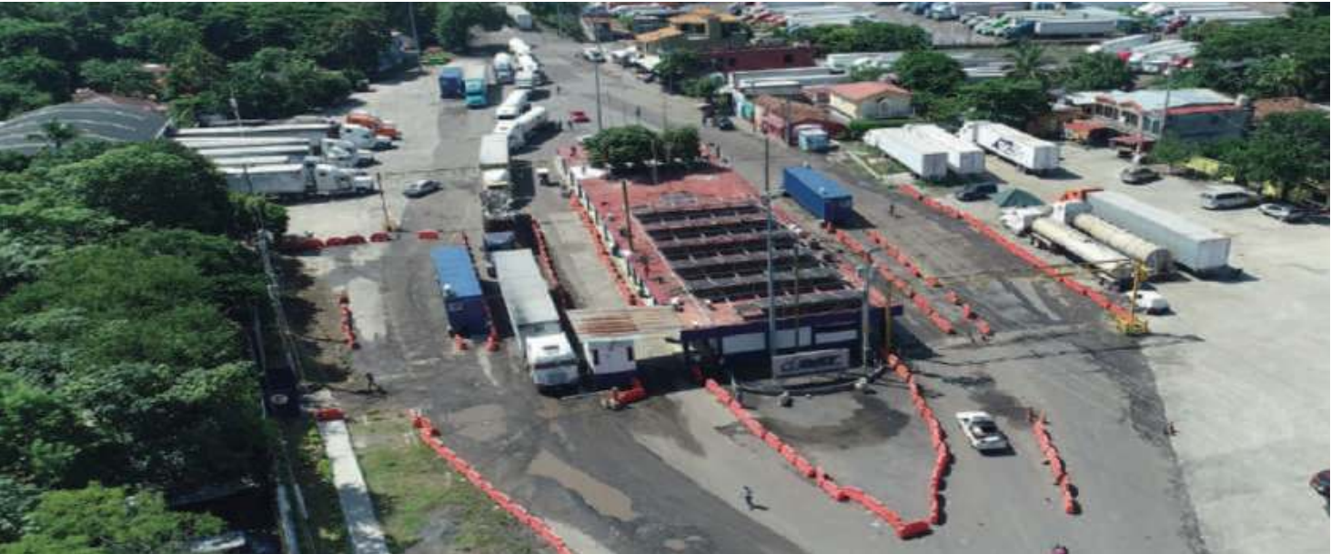
Vista aérea del Puesto Fronterizo de Aduana Pedro de Alvarado, Guatemala. 2021.
