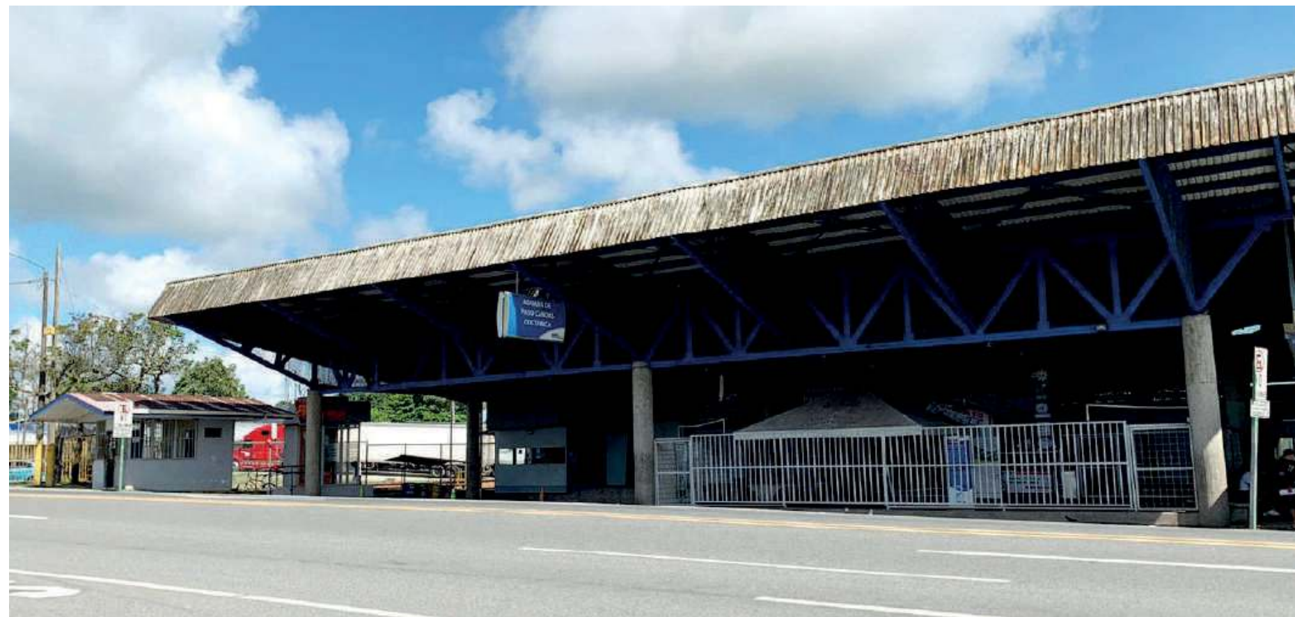
Puesto Fronterizo Aduana Paso Canoas, Costa Rica. 2021.
