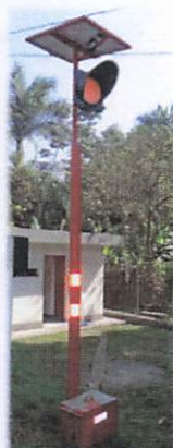
DETALLE DE SEMAFORO SEMAFORO SOLAR
