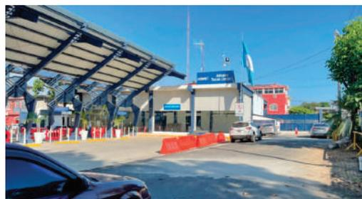
Instalación de estructura metálica vehicular (techo) nueva área de verificación, trabajos de señalización horizontal, mejoramiento de accesos vehiculares en la Aduana Tecún Umán I.
